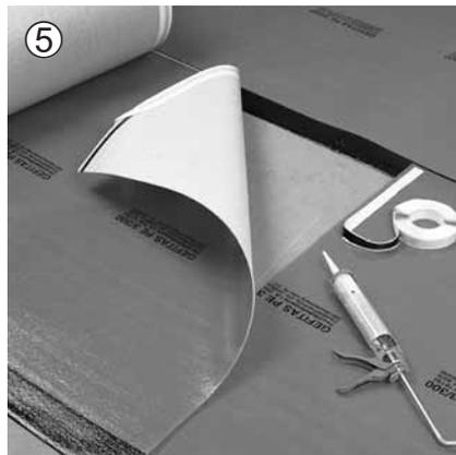
Die Querstöße, z. B. am Rollende, werden mit dem **GEFITAS®** Dichtband abgedichtet. Die Überlappung beträgt 5 - 10 cm.
