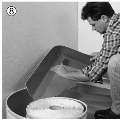
Die Ecke lässt sich leicht formen und anschließend mit **GEFITAS®** Bitumen Dicht- und Klebstoff aus der Kartusche verkleben.
