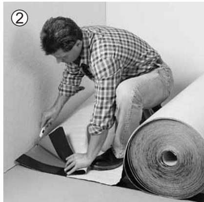
An der Stirnseite bündig zur Wand abschneiden und die nächste Bahn bis zum schwarzen Aufdruck überlappend ausrollen.
