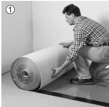
Die **GEFITAS®** Feuchtigkeitssperre PE 3/300 an der ersten Wand entlang ausrollen. Die Klebung zeigt zur Wand, die blaue Seite nach oben.
