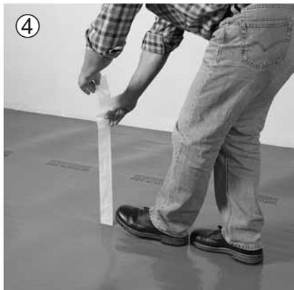
Während Sie den Schutzfilm abziehen, können Sie gleichzeitig die Bahnen durch Druck mit dem Fuß auf den Butylkleber fest miteinander verbinden.
